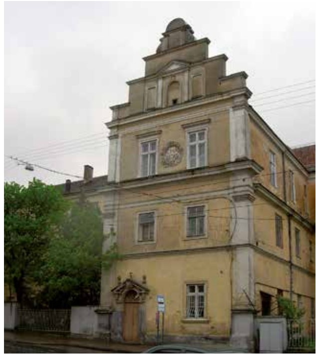
Rycina 3. Budynek 6. Szpitala Okręgowego, Lwów, 2006 r.
