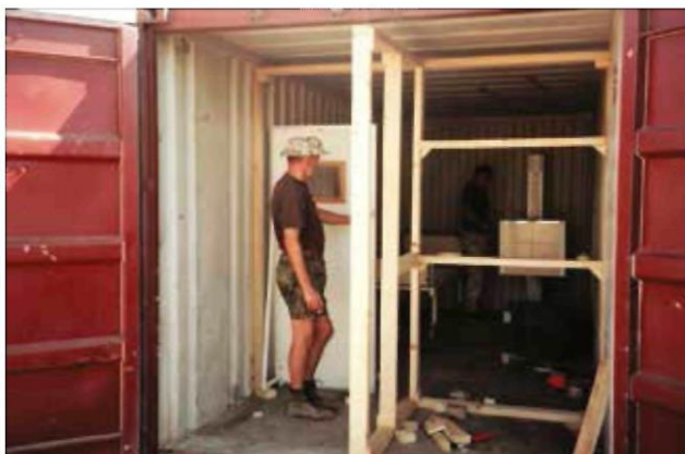
Figure 17. Darkroom under construction in a 20ft container, built by the radiological team and evaluation of placing an x-ray unit inside the container. Camp Lima, 11 Sep 2003 (source: L. Kolarz) Rycina 17. Budowa ciemni w 20-stopowym kontenerze przez zespół radiologiczny oraz ocena możliwości budowy gabinetu RTG w kontenerze, Camp Lima, 11.09.2003 r. (źródło: L. Kolarz)
