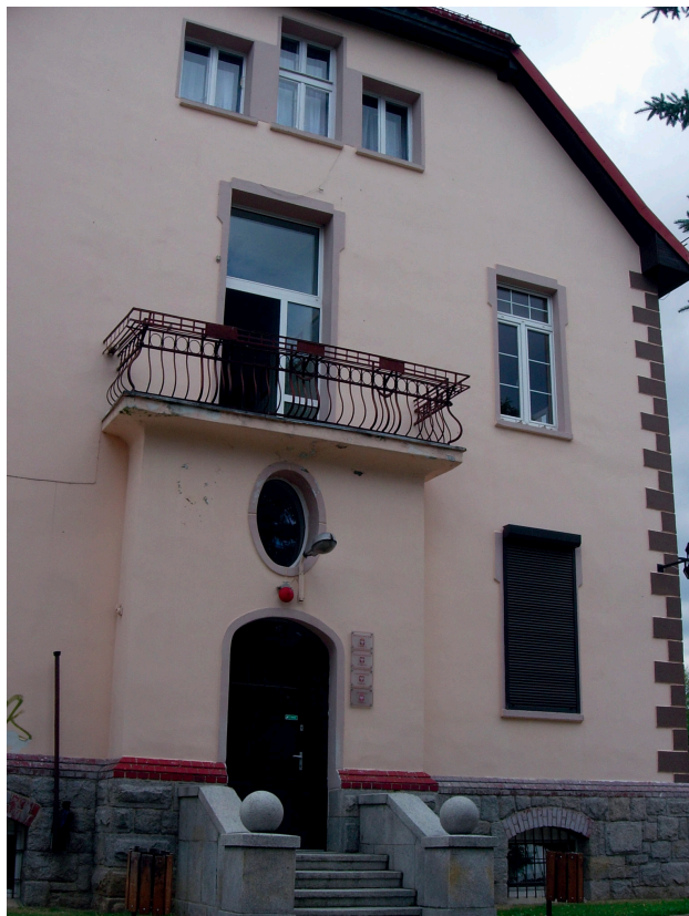
Rycina 4. Wejście główne do budynku dawnego Szpitala Miejskiego w Sobótce od strony ulicy Świętego Jakuba (dawniej Armii Czerwonej 28), Sobótka, 2015 (fot. Z. Kopociński)
