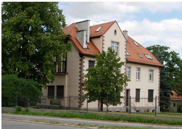
Rycina 3. Budynek dawnego Szpitala Miejskiego w Sobótce od strony alei Świętej Anny, obecnie Powiatowy Zespół Szkół nr 3 w Sobótce, Sobótka, 2015 (fot. Z. Kopociński)
